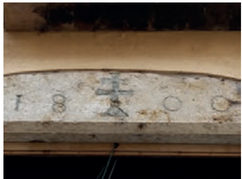
Llinda d'un balcó d'una casa de Besalú.
