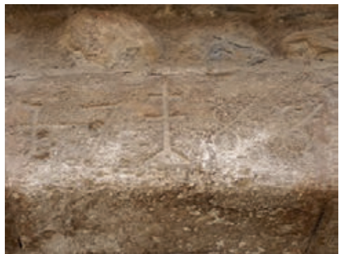
Llinda de la porta d'entrada d'una casa de Besalú.
