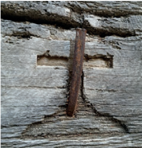
Llinda de fusta de la porta d'entrada d'una casa de Besalú.
