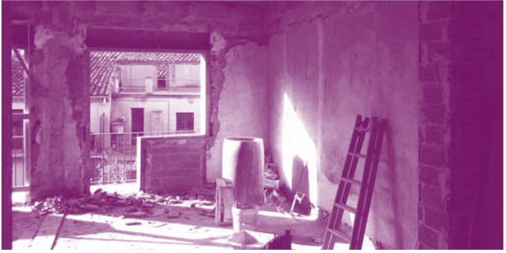
| La sala en fase d'obres
