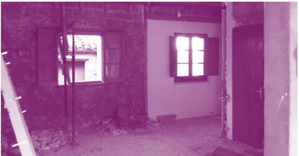
| La sala en fase d'obres
