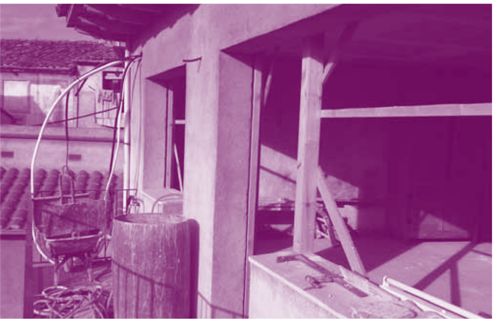
La sala en fase d'obres
