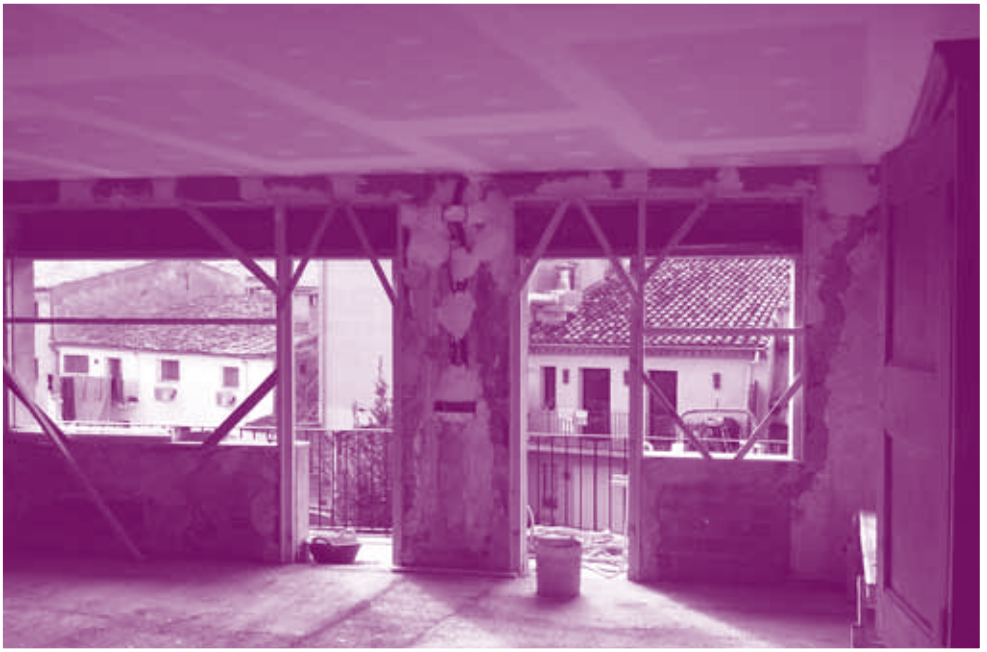
La sala en fase d'obres
